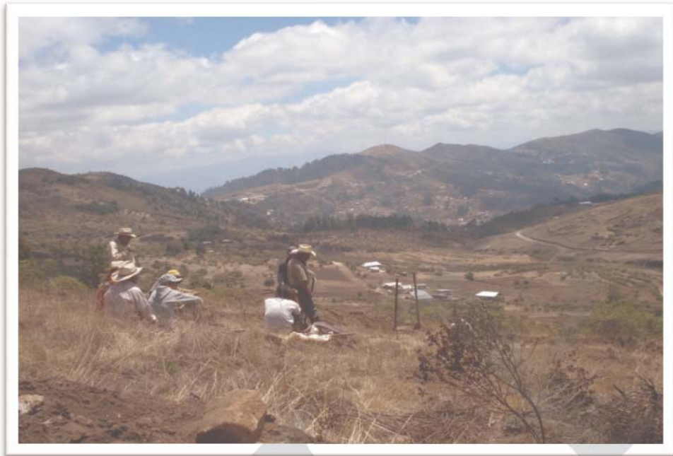
Foto 3. Construcción de zanjas y pozos de infiltración en San Antonio, micro región Cutzulchima
